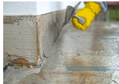
Verfüllen der Hohlstellen an dem Sockelbereich des WDVS mit PMMA-Spachtel.
