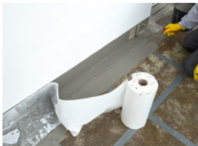
Passgenaues, flüssiges Abdichten des WDVS-Sockelbereichs und der Türelemente in der selben Arbeitsfolge.
