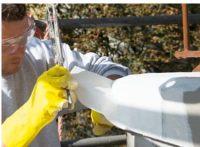
Die Aluminiumprofile wurden in die naht- und fugenlose, vliesarmierte Flüssigabdichtung eingebunden.
