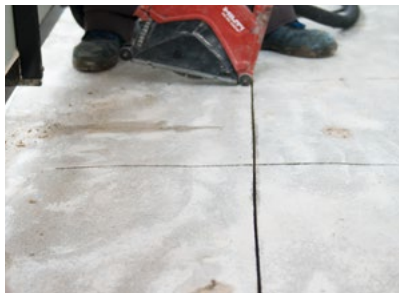
Integrieren der Kanäle in den vorbereiteten Untergrund, bestehend aus Estrich und Fliesenbelag.
