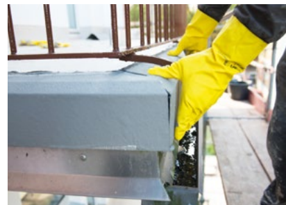
Nach dem Abdichten der Fläche und der Aluminiumprofile wurden diese als Kantenschutz mit PMMA-Spachtel eingebettet.
