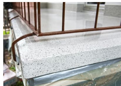
Anschließendes Versiegeln der Oberfläche mit Wecryl-Finish, das mit dekorativen Chips versehen wurde.
