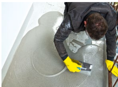
Auftragen des Wecryl-Verlaufmörtels. Er schützt die Abdichtung sicher vor Punktbelastungen.
