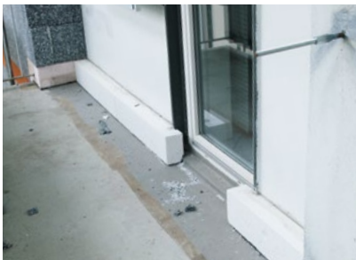
Vor dem Einbau des WDVS wurden Wandaufkantungen und Türelemente auf der Konstruktionsebene abgedichtet.
