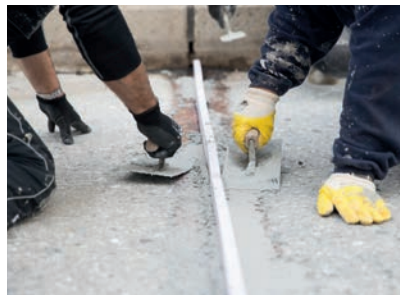
Die Fugen wurden mit dem WestWood Wecryl 846 Beton-Instandsetzungsmörtel reprofiliert, der bereits nach 30 Minuten ausgehärtet war.
