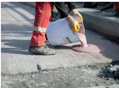
Bereits nach ca. 60 Minuten wurde die Grundierung Wecryl 123 mit dem Wecryl 123 K überarbeitet.
