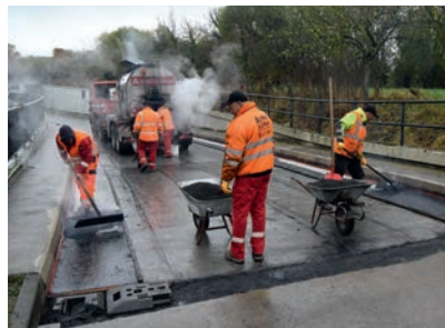
Die Gussasphalt-Schutzschicht wurde zunächst im Randbereich, dann in der Fahrbahnmitte eingebaut.
