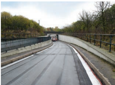
Die Dichtungsschicht wurde mit der Polymerbitumen-Schweißbahn VEDAPONT BE von VEDAG ausgeführt.
