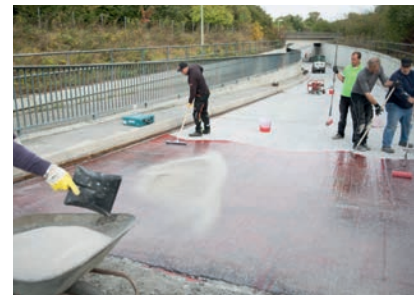
Mit Gummischiebern verteilten die Fachverleger die Grundierung Wecryl 123 die mit Quarzsand 0,2-0,7 mm abgestreut wurde.
